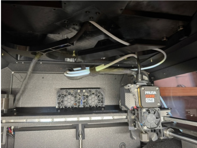
Abbildung 68 Innenansicht der endgültigen Kabel- und Schlauchinstallation.
